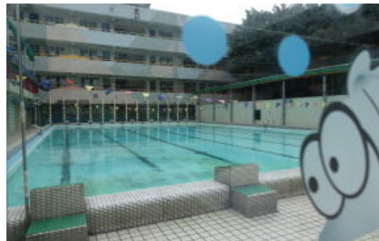
⑭ 小学校プール（ワイヤーで屋根を張る ことができる。）
